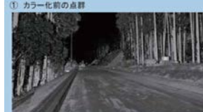
道路舗装工事の HDR 画像と点群
